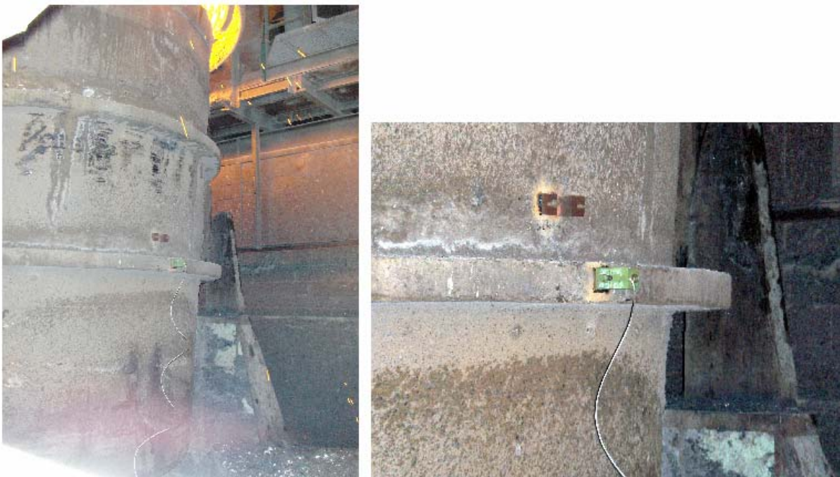
Fig.1 Fotografía de la cuchara siderúrgica con el primer sensor de vibraciones utilizado
